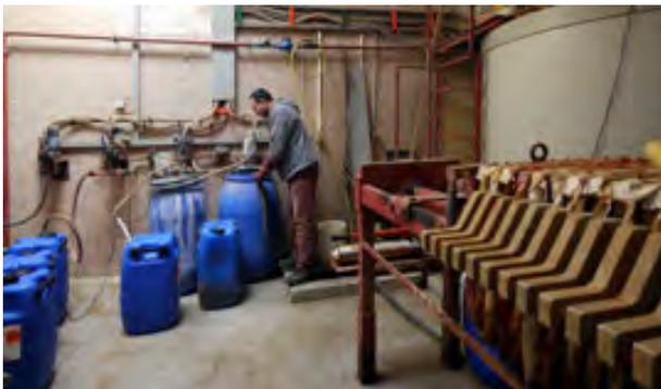
*Bild 1: Arbeit bei der Abwasserbehandlung. Links im Bild die Chemikaliendosierstation, wo gerade Flockungsmittel neu angesetzt wird.*
